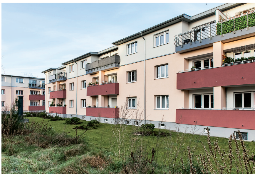
Zwei Wohngebäude mit gemeinsamem Nahwärmenetz
