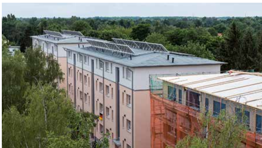
Foto 2: Sanierte Gebäude in Berlin
