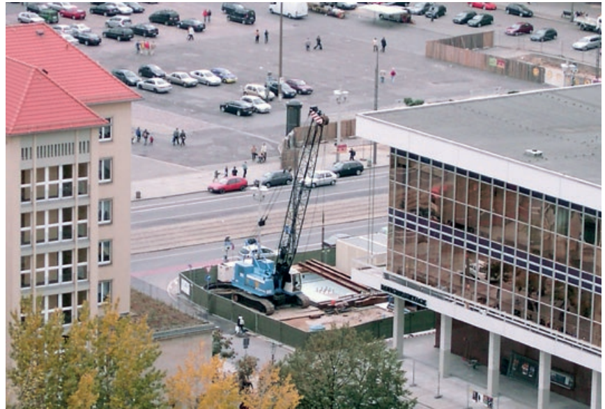
Abb. 6 Blick von der Frauenkirche auf die HBr-Baustelle Kulturpalast
